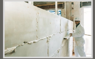
2- Colocación de filas sucesivas.
