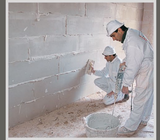
4- Afeitado de juntas.
