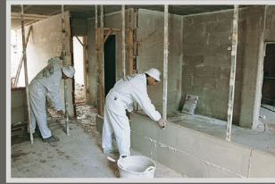
1- Colocación de reglas y 1ª hilada.
